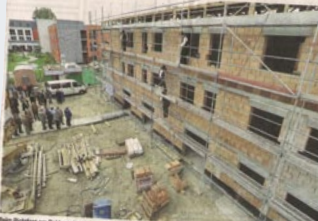
Beim Richter am Rohbau des neuen Lebenshilfe-Wohnhauses zeichnen vier Zimmerleute den traditionellen Holzbau nach. Neben sie auf dem Baugrund die Fassade angebrachten waren.
